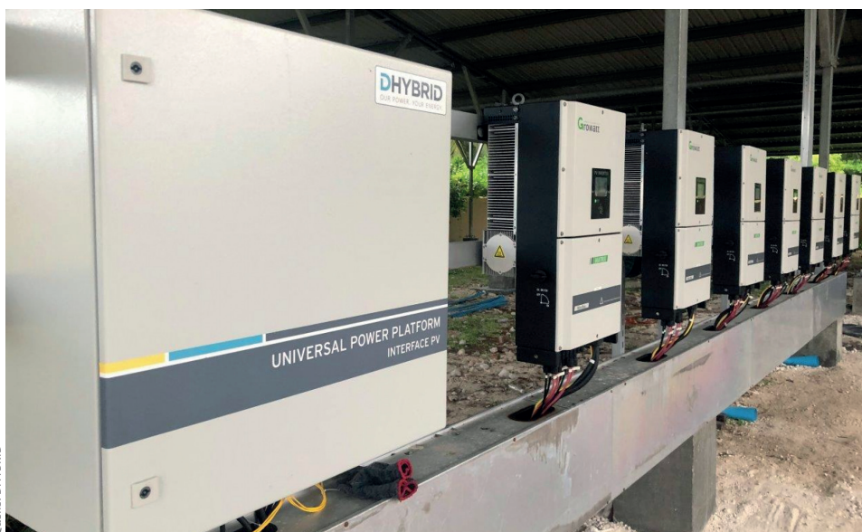
Bild 1. Die Universal Power Platform (UPP) ermöglicht die intelligente Kombination und Steuerung von Batteriespeichern und erneuerbaren Energien in hybriden Anwendungen.
