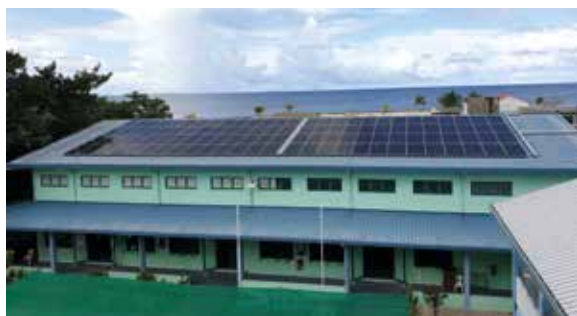
02 Photovoltaik in Kombination mit Batteriespeichern reduziert die Betriebszeit der Dieselgeneratoren
